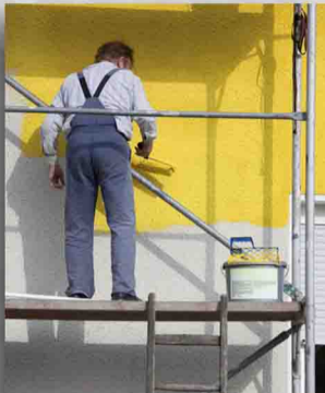
Travaux De Peinture
