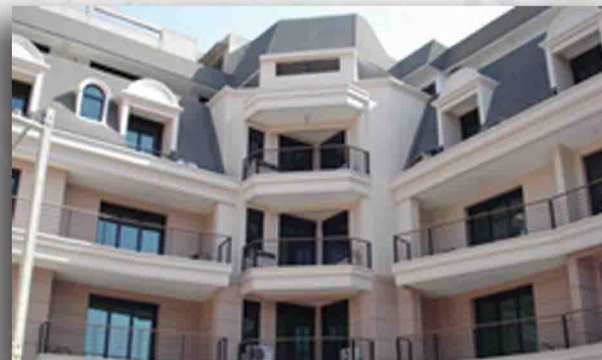
Travaux Bâtiment Tout Corps D'état
