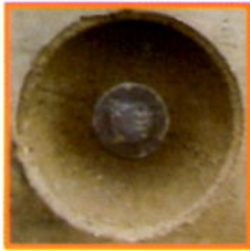
Ancre de Levage
